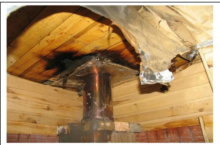
произойдет пиролиз древесины. Признак начала пиролиза — потемнение деревянных деталей. Такие участки в деревянной обшивке необходимо своевременно заменять новыми. Чтобы не происходил перегрев, рекомендуется часто
